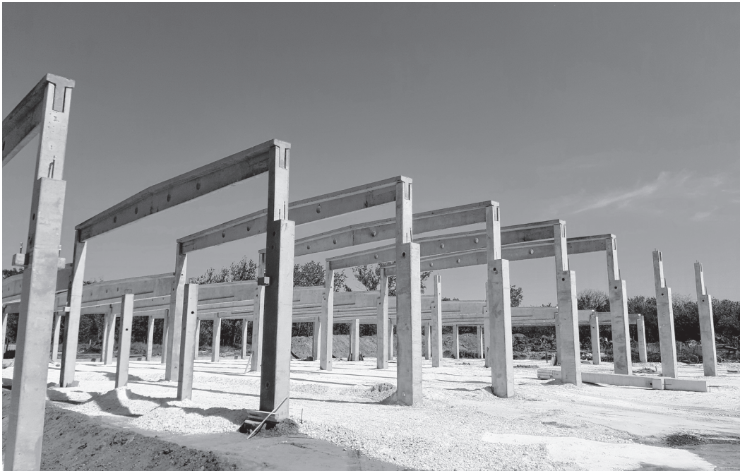
A Ferrobeton által gyártott vasbeton szerkezetek a Schiller Autószalon és Szerviz építésén Fotó: Ferrobeton
